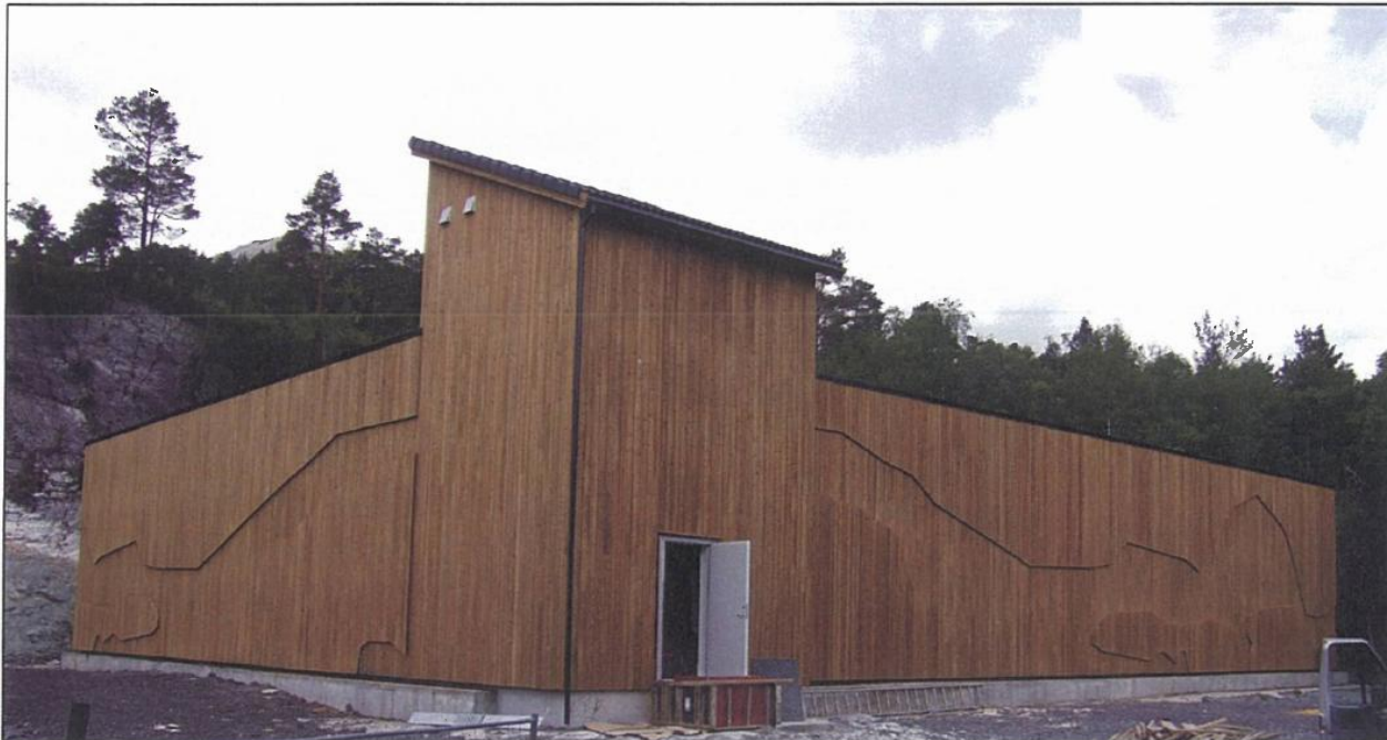
Nytt vassreservoar ved vasshandsamingsstasjonen.
