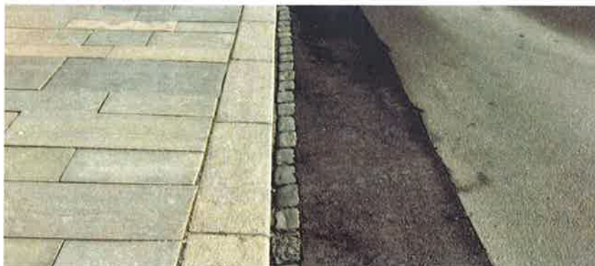
Vatn må ikkje trengje inn i vegen og skøytear skal difor vere tette.
