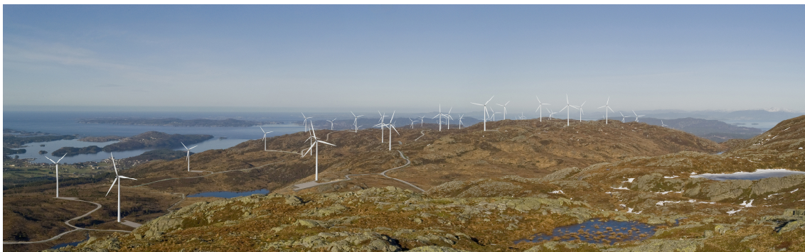
Montasje: Midtfjellet Vindpark AS
