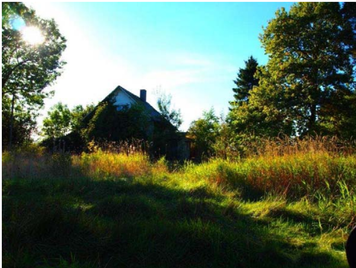
Bygga på eigedommen gnr 26 bnr 107 er falleferdige og tomta grodd igjen.
