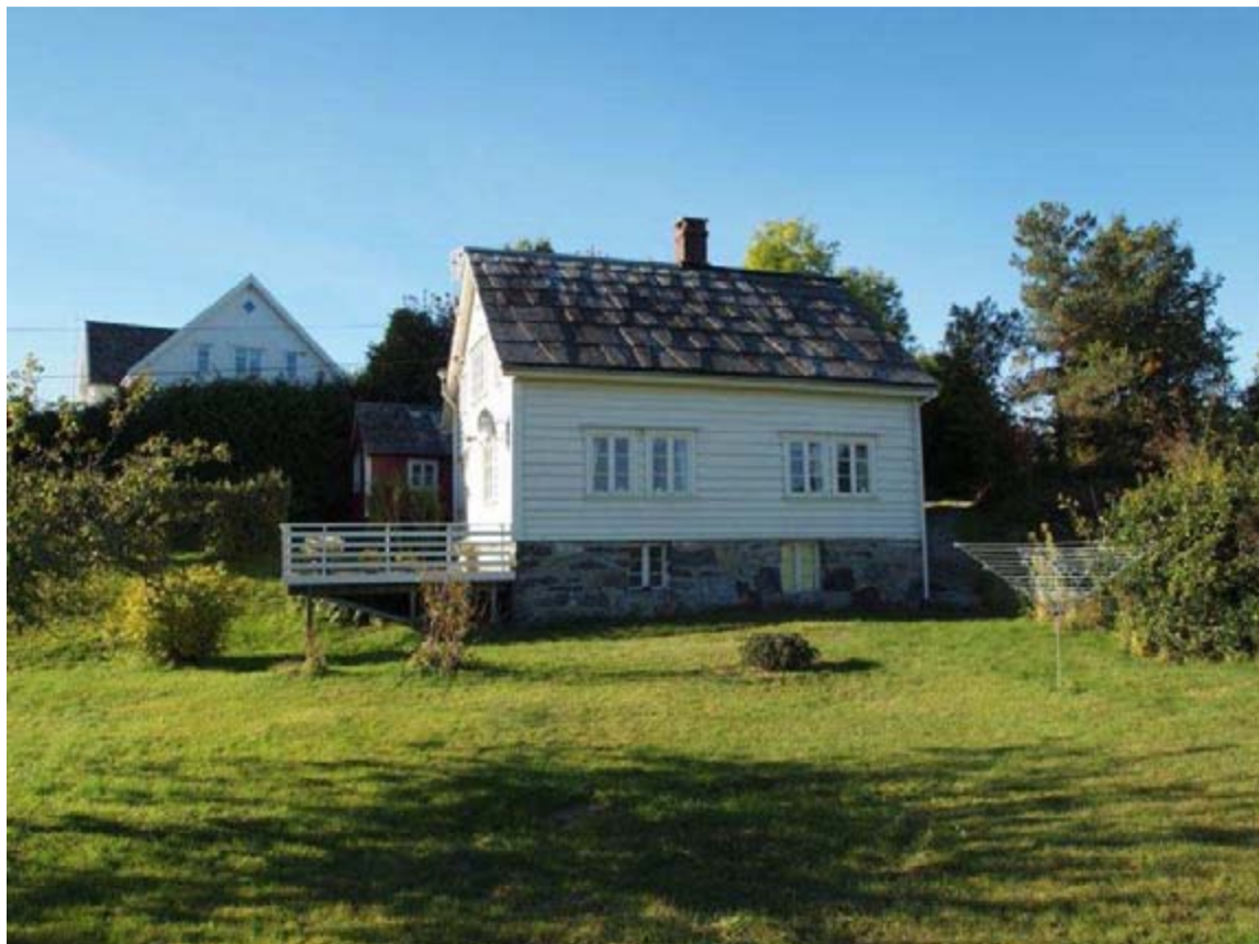
SEFRAK-registrert bygg 1 og 2: Hovudhuset på garden frå før år 1900, god stand og det er brukt som fritidsbustad i dag. Ein ser og stabburet bak i tilknytning til det.
