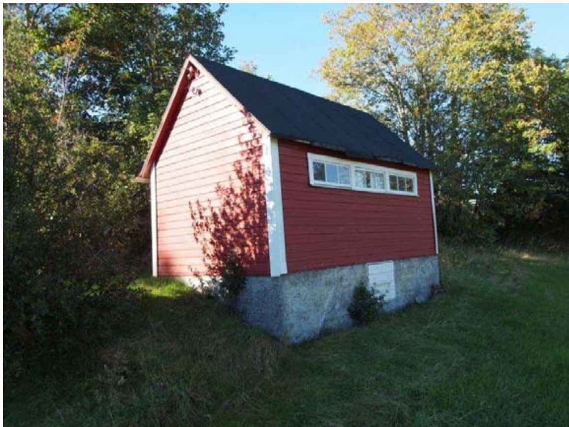
SEFRAK-registrert bygg 7: Uthus som er middels godt bevart.
