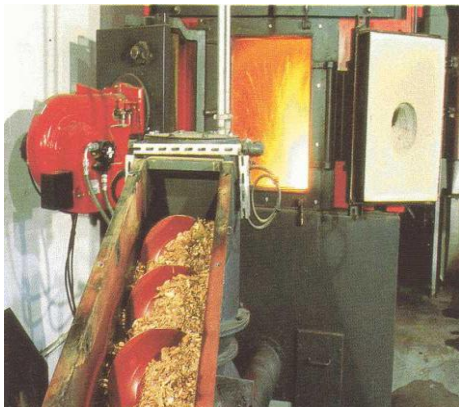
Figur 6.1 viser biokjele med skruemating av flis
