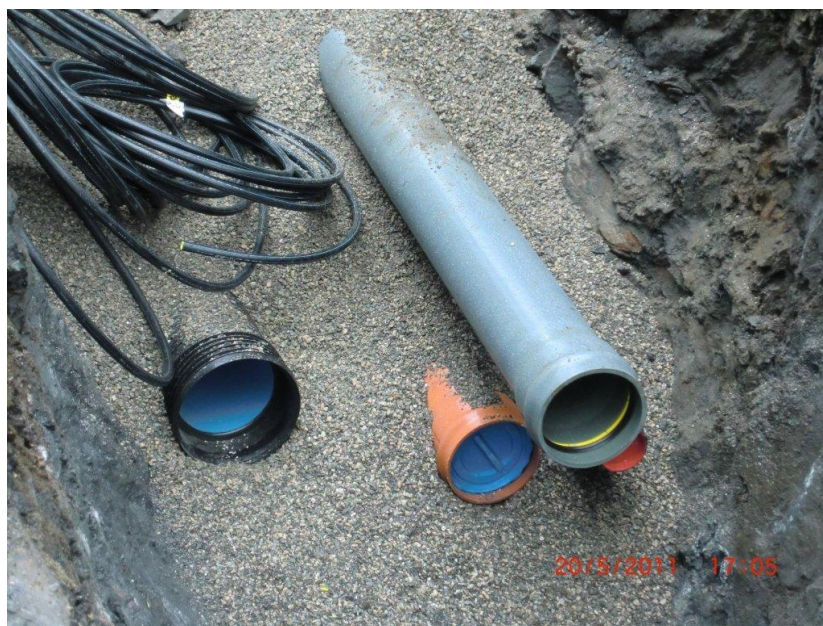
Figur 13 Legging av nye avløps- og vassrøyr
