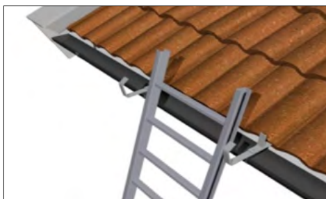
Stige under 5 meter skal sikrast mot utgliding, velting sidelengs eller bakover.
