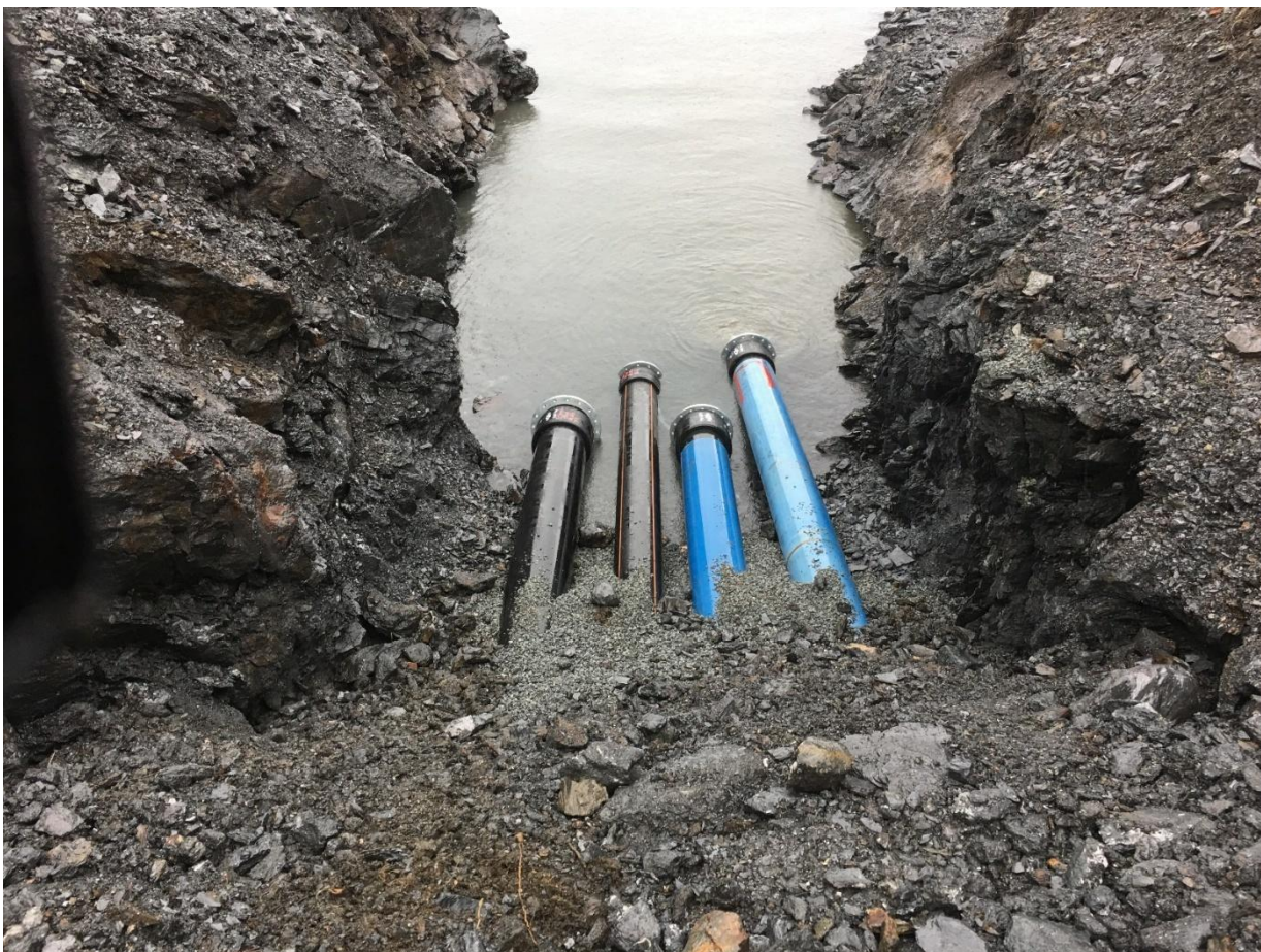
Figur 7: Etablering av landtak for vass- og avløpsleidningar i strandsona ved Kårevik.
