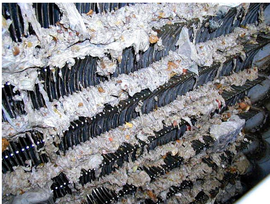
Figur 4-2: Illustrerer funksjonen til en rist, her trapperist, som fjerner avløpssøppel og større partikler for å redusere driftsutfordringer i videre renseprosesser. Trapperist STEP SCREEN®s - Hydropress Huber AB avd.Norge
