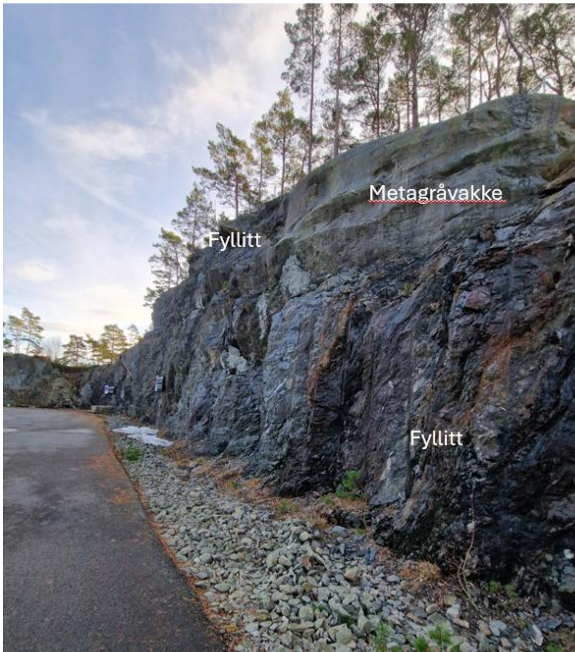
Figur 11: Mindre metagråvakke overlatt fyllitten i den sentrale delen av skjæringen – se også Figur 10.
