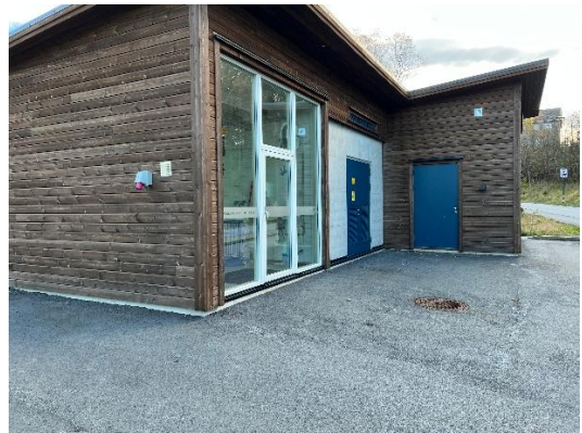
Figur 14: Eldre og dårleg vasskum utan botn og forankring av leidningane opp t.v. Oppe t.h. er plassbygd vasskum og nede t.h. er Byrkjelandsløken stasjon. Byrkjelandsløkjen stasjon består av både avløpspumpestasjon, vassmålarstasjon og transformator.
