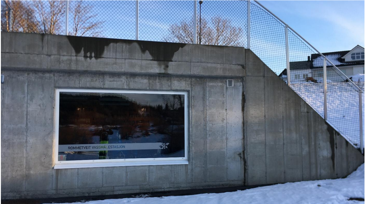
Figur 17: Rommetveit vassmålarstasjon etablert i 2018.
