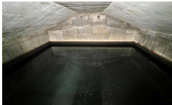
Figur 16: Lundsåsen trykkutjammingsbasseng. Utvendig t.v. og innvendig t.h. Bassenget har også eit ventilkammer med vassmålarar.
