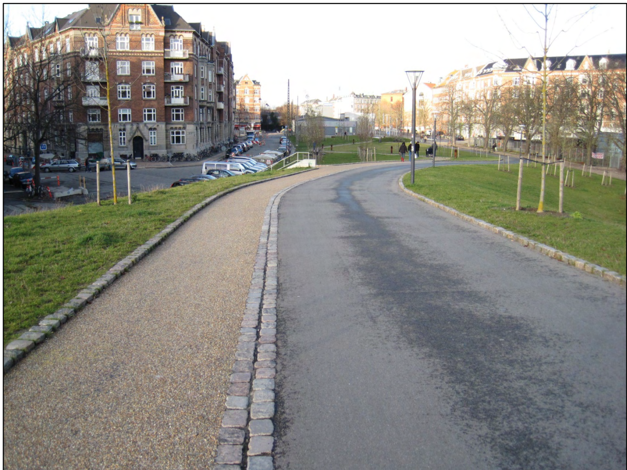
Figur 3: Eksempel på sykkelveg med fortau fra København
