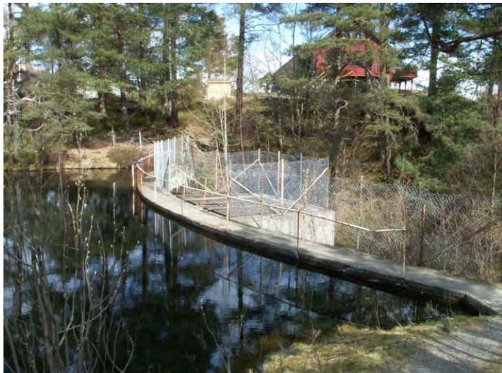
Figur 5 Det gamle vassverket i Lønningsåsen
