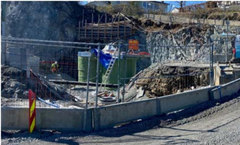
Bilete: Anleggsarbeid med nye Lyngneset avløpspumpeasjon
