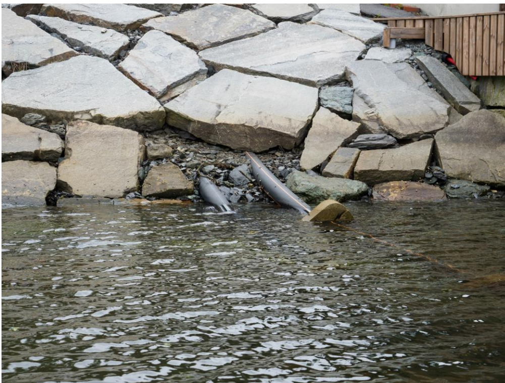
Figur 3. Fylling med rørledninger fra Tømbervika avløpspumpe­stasjon. Foto: Multiconsult.
