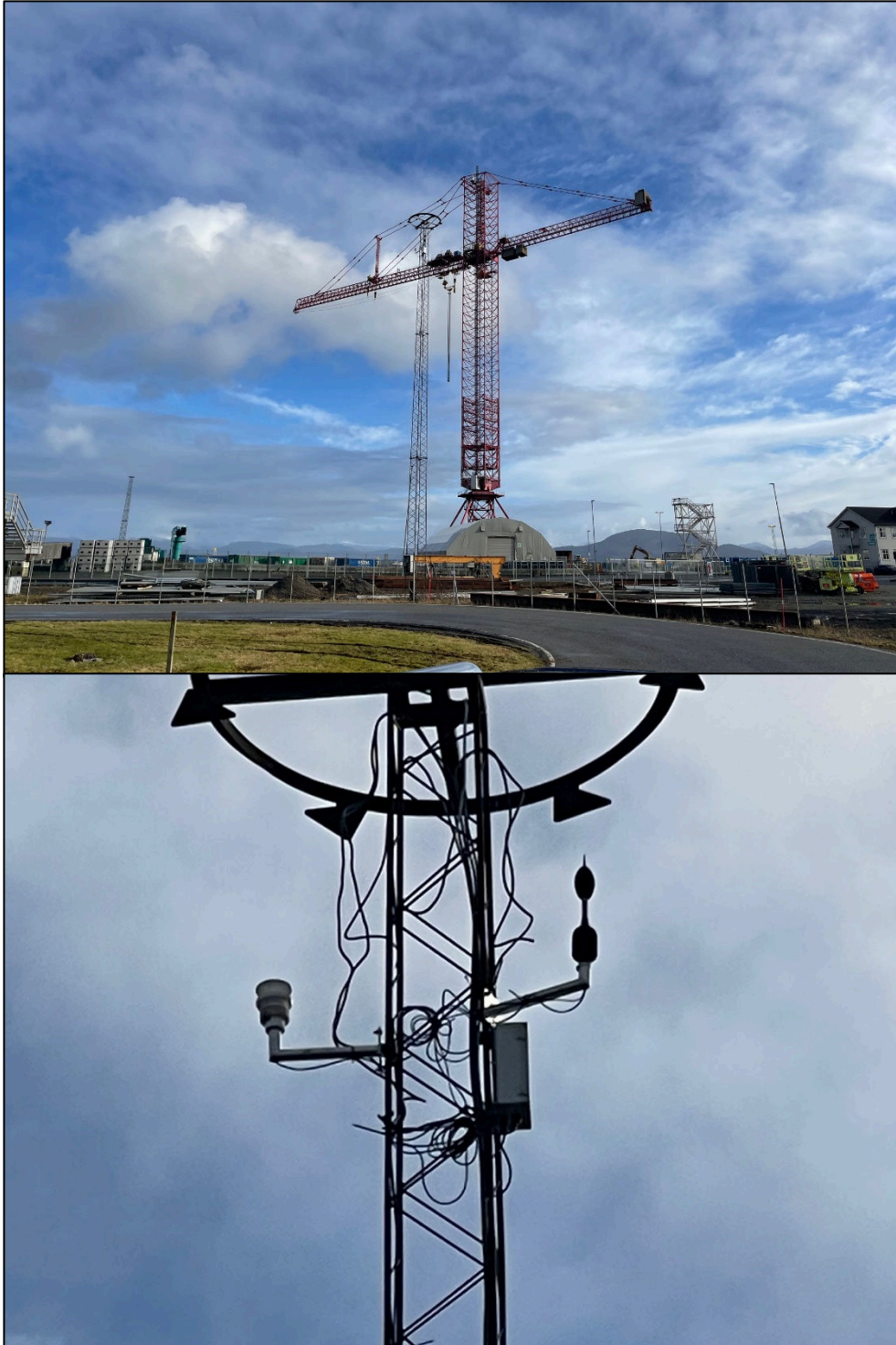
Figur 1-2: Bilde av mast er vist øverst og bilde av målestasjon 1, som er montert på mast, er vist nederst. Det er også montert en værstasjon som henter inn meteorologiske data, som vindstyrke og vindretning. Bildene er tatt av Stord Hamn og tilsendt 17.02.2022.
