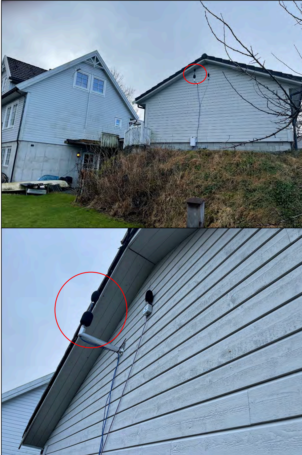
Figur 1-3: Bildene av målestasjon 2 som er montert på den østvendte veggen til garasjen i Kårevikvegen 80. Målestasjonen er markert med en rød sirkel. Bildene er tatt av Stord Hamn og tilsendt 18.02.2022.
