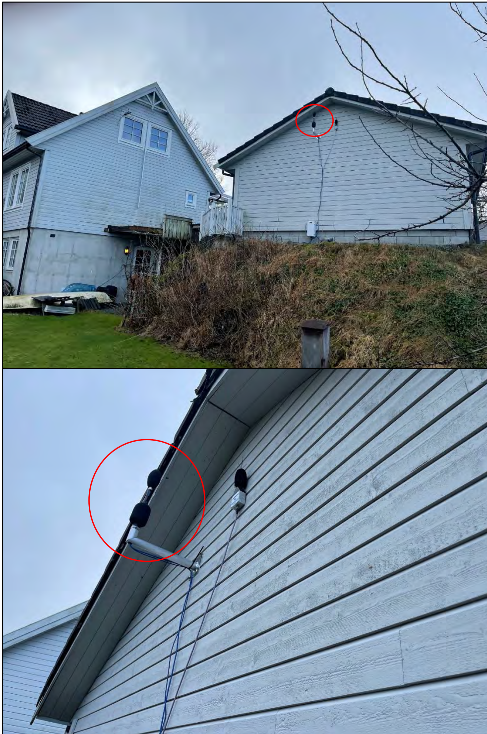
Figur 1-3: Bildene av målestasjon 2 som er montert på den østvendte veggen til garasjen i Kårevikvegen 80. Målestasjonen er markert med en rød sirkel. Bildene er tatt av Stord Hamn og tilsendt 18.02.2022.
