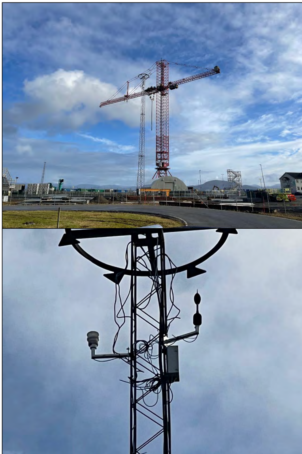
Figur 1-2: Bilde av mast er vist øverst og bilde av målestasjon 1, som er montert på mast på industriområdet, er vist nederst. Det er også montert en værstasjon som henter inn meteorologiske data, som temperatur, luftfuktighet, nedbør, vindstyrke og vindretning. Bildene er tatt av Stord Hamn og tilsendt 17.02.2022.
